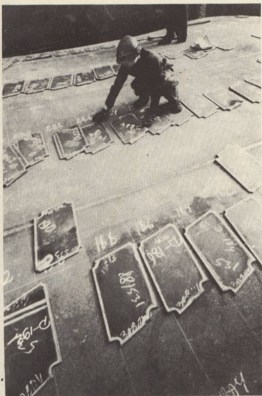
Первый цех будущего корабля — корпусозаготовительный.
